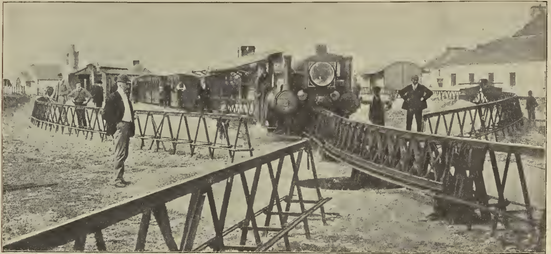
FERROCARRIL DE UN SOLO RIEL, SISTEMA BEHR, QUE ACTUALMENTE FUNCIONA EN DALLYBUNION (IRLANDA)
